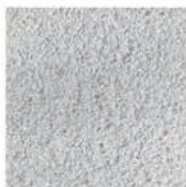
施工直後のUP
