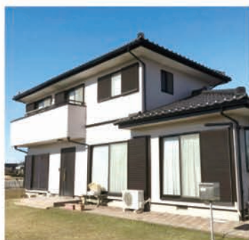
2016年施工直後の様子
