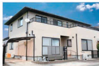
色：メリーノ 施工時期：2017年12月
