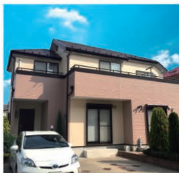
2016年施工直後の様子
