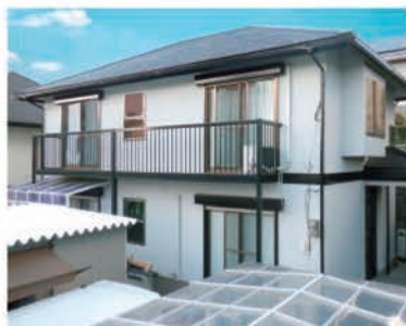
施工直後の様子
