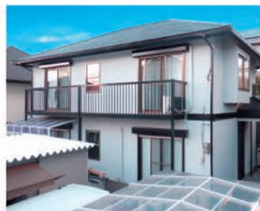
施工から5年経過後の様子
