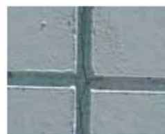
可塑剤が気化し、伸長性を失った塗膜・シーリング材
